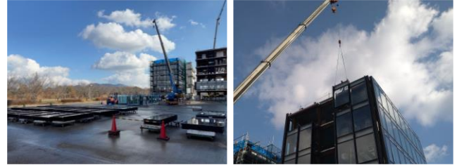
Fig. 4 カーテンウォール施工状況 (UN方式)
